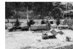
1974 開発センター内に ごみ中継基地 モデル・プラント建設
